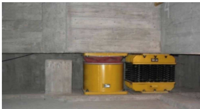
Рисунок В.12 - Установка ТПДС при параллельном размещении блока витых пружин и ВД
