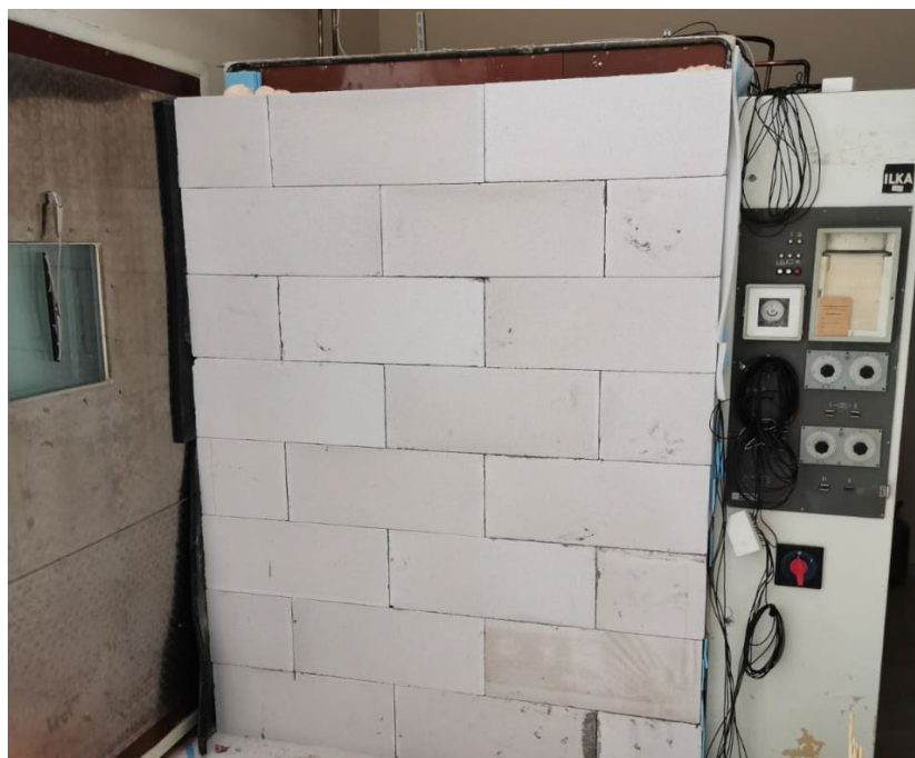
Рис. 3 Смонтированная кладка перед установкой датчиков с внешней стороны
