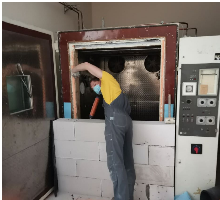
Рис. 1 Процесс монтажа кладки перед проемом климатической камеры
