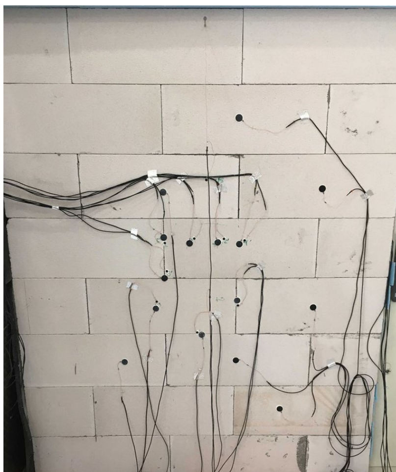
Рис. 4 Поверхность кладки, обращенная в лабораторное помещение, с установленными датчиками (с «теплой» стороны)
